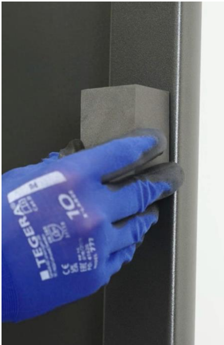
Abbildung 38: Abstandshalter positionieren
