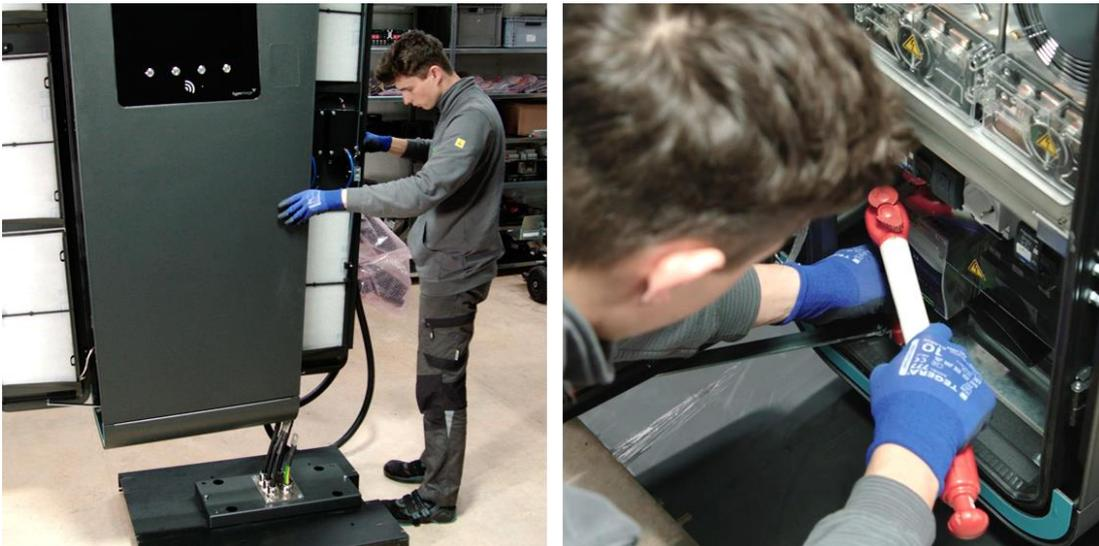
**Abbildung 48:** Positionierung HYC400 auf Sockel und Befestigung
