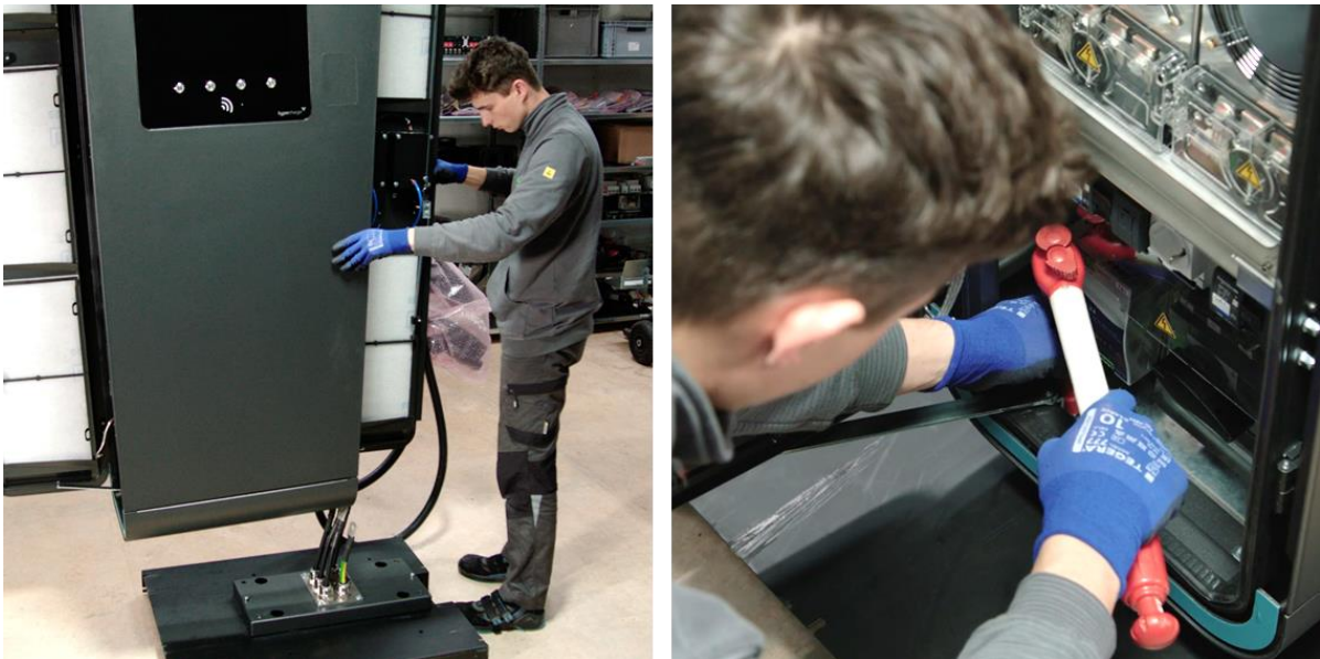
Abbildung 54: Positionierung HYC200 auf Sockel und Befestigung
